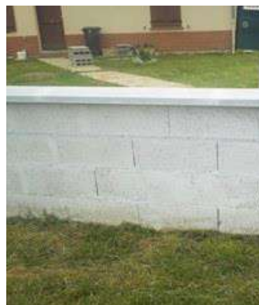
MUR DE CLOTURE NON ENDUIT
