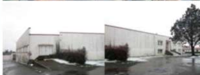
Photographies avant démolition
