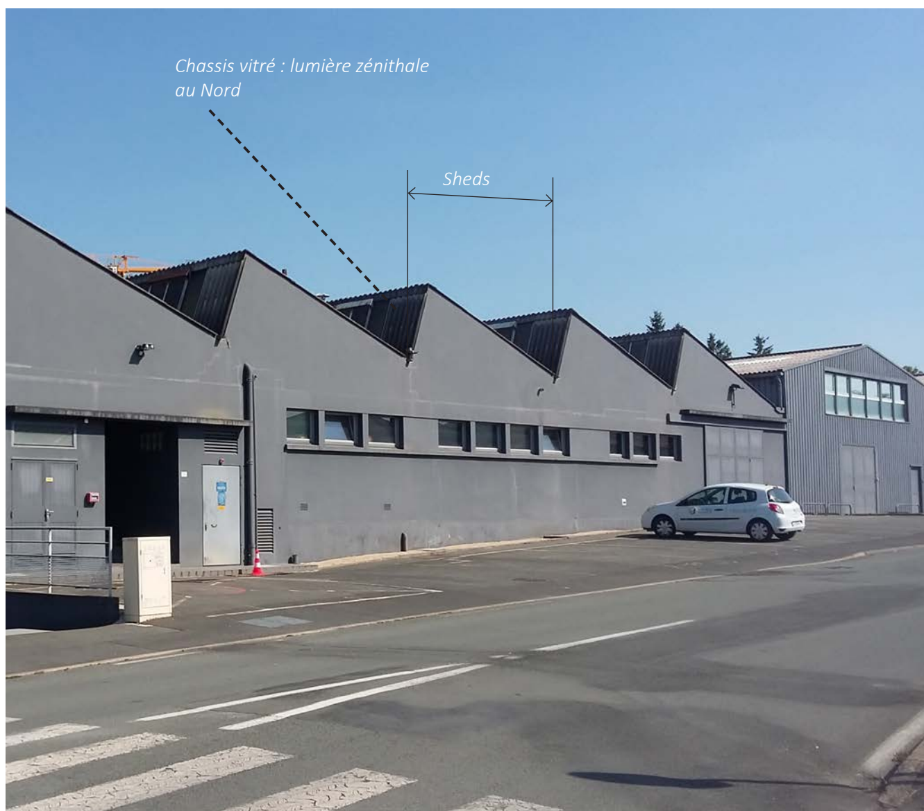
Entrepôt, La Gaubretière
