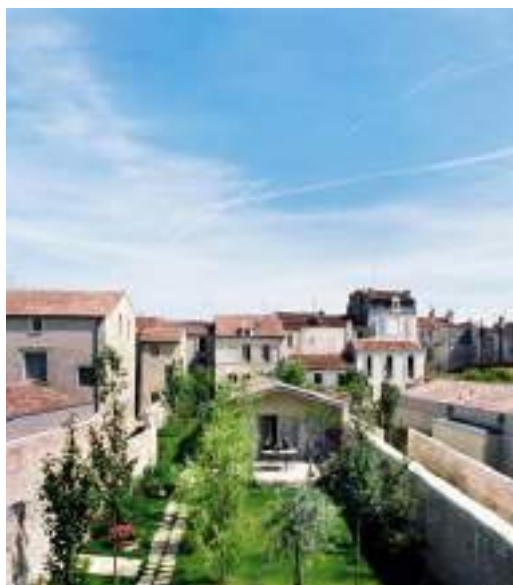
Saintes (17), BNR architectes
