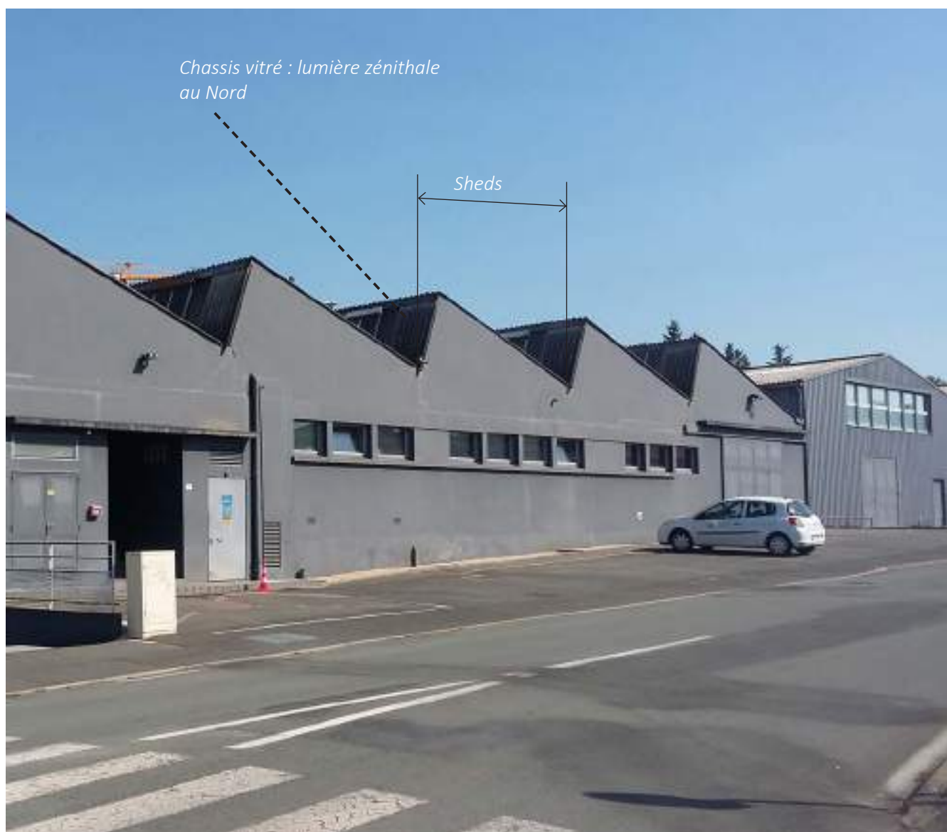
Entrepôt, La Gaubretière
