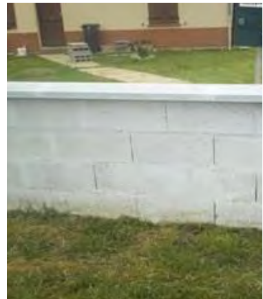
MUR DE CLOTURE NON ENDUIT
