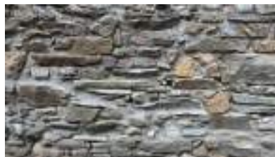
illustration mur en moellons
