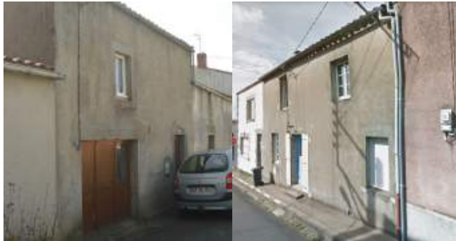
Fig. 71. Exemples de façade en enduit ciment
