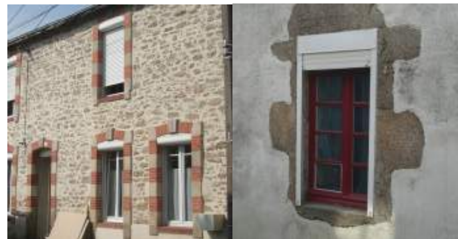
Fig. 73. Exemples de coffres de volets roulants en PVC visibles de l'espace public
