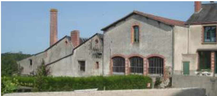
Fig. 36. Ancienne horlogerie de la rue des Moines
