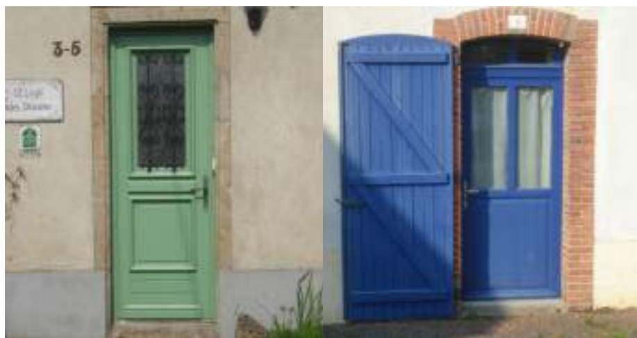
Fig. 44. Portes vitrées avec soubassement
