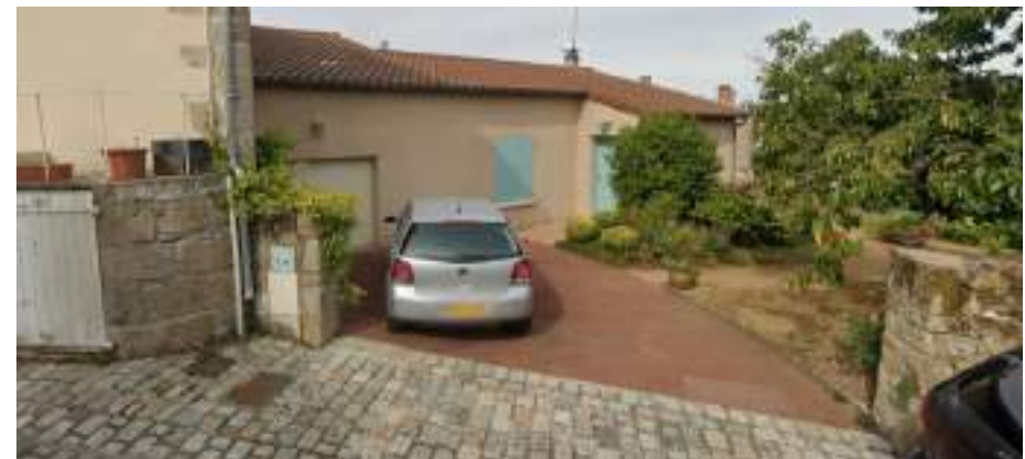
Fig. 83. 2bis, rue du Château
