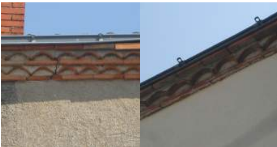
Fig. 49. Corniches en génoise
