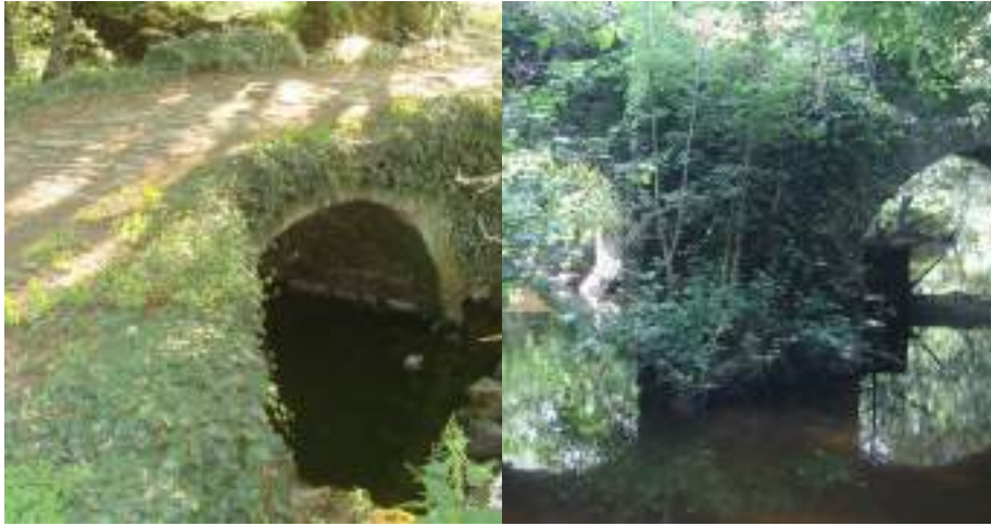
Fig. 57. Ponts sur la Crûme
