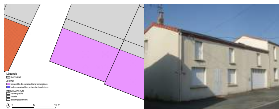
Fig. 95. Réévaluation de la valeur du bâtiment du 7 rue Saint Aubin Source : A4PLUSA
