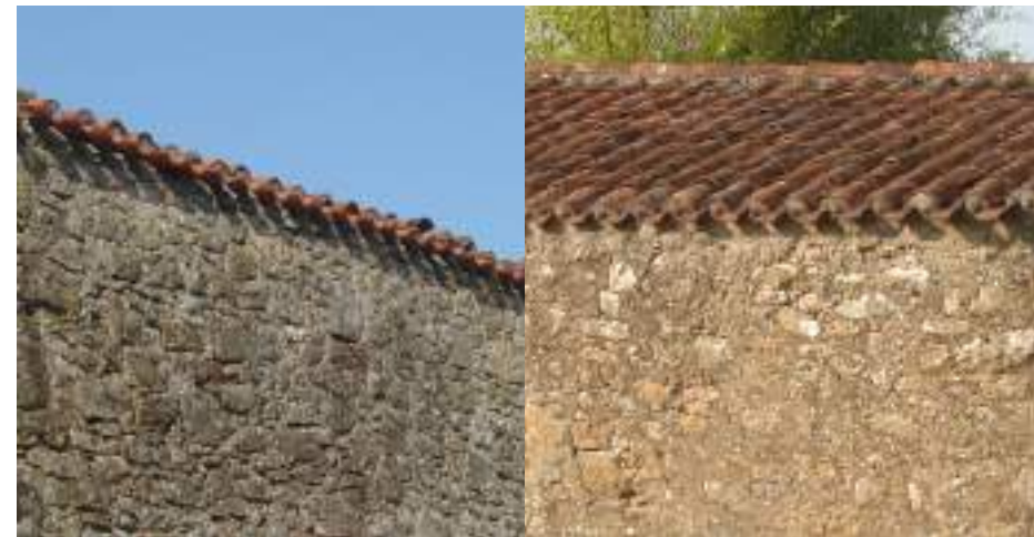
Fig. 48. Corniches à égout simple
