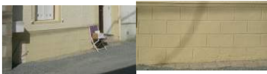
Fig. 41. Soubassement en mortier
